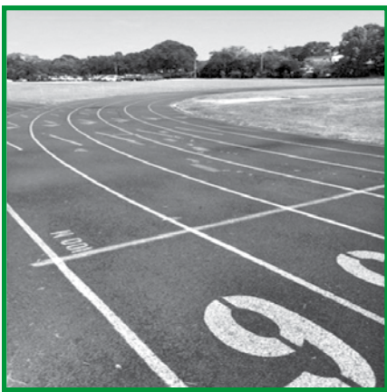
Track repair Reparación de vías
